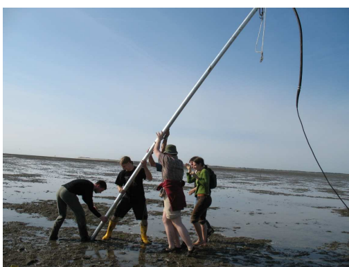
Aufrichten des Bohrgestänges
